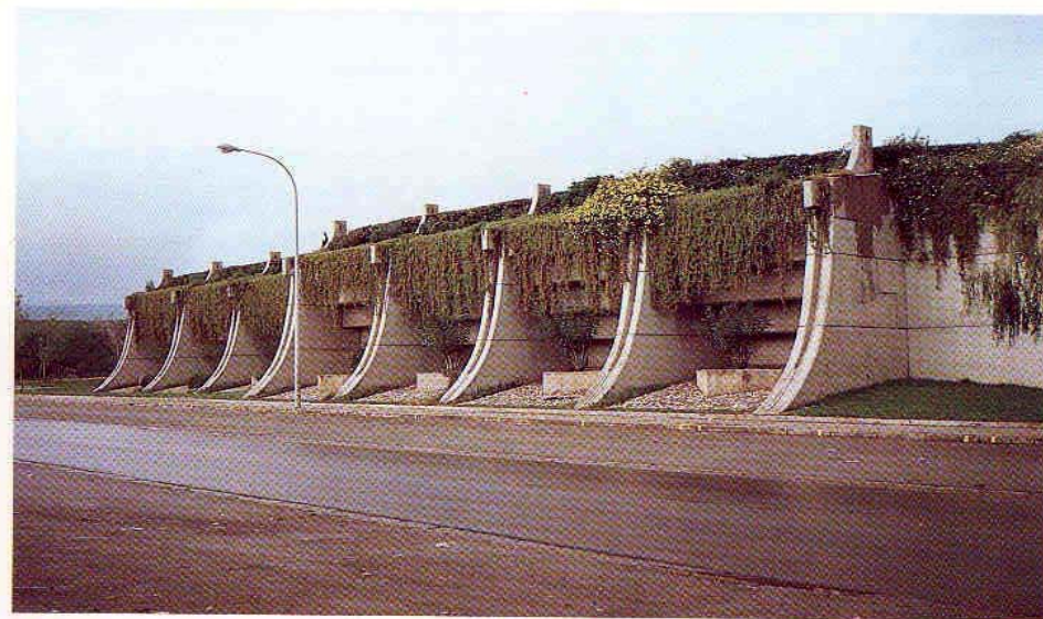
Mur de contenció del Clos Arqueològic de Torre Llauder.
