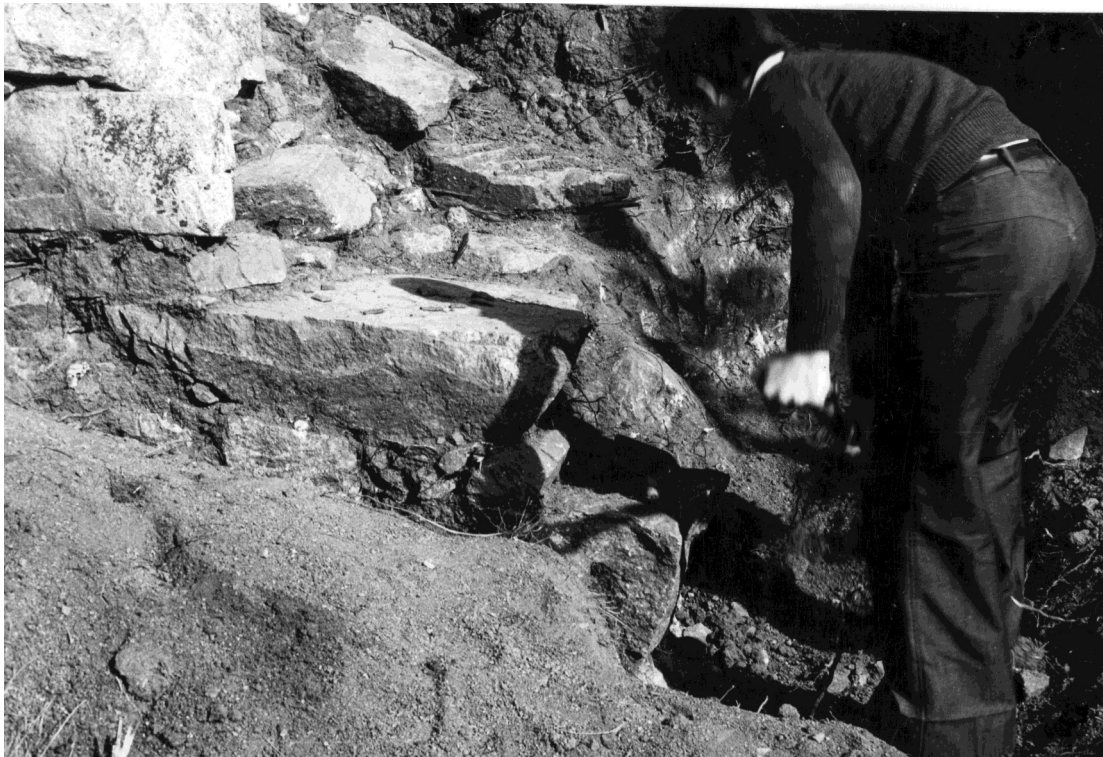
Treballs de neteja de la part alta de la torre ibèrica del Turó dels Dos Pins.
